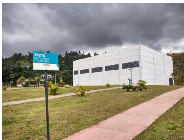
Figura 359. Novo ginásio em implantação
