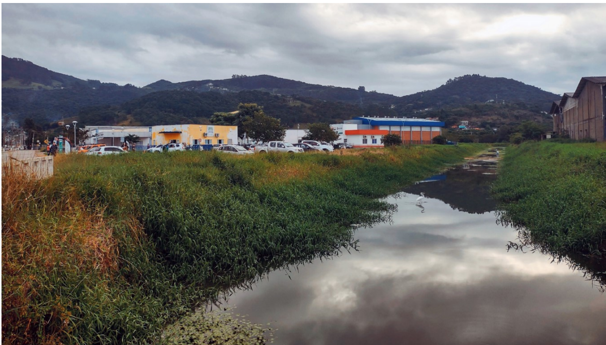
Figura 416. Canal retilizado no bairro Fundos, nas proximidades da UPA
