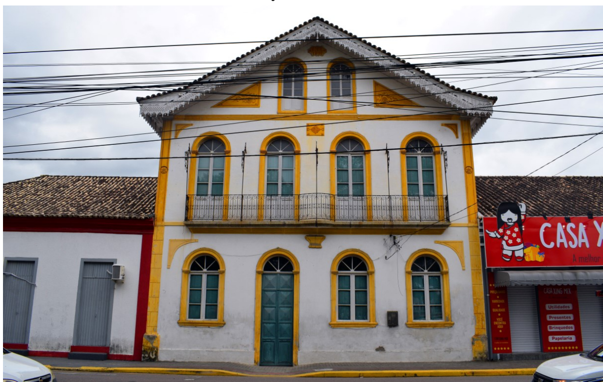
Figura 423. Fiação elétrica aérea concorrente com a apreensão do Casarão Born a partir da Praça Nereu Ramos
