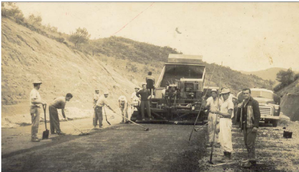
Figura 101. Construção da BR-101 em Biguaçu (década de 1960)
