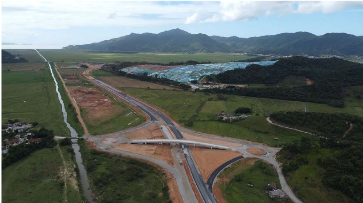
Figura 413. Aterro Sanitário e obras do Contorno Viário da BR-101, abril de 2023
