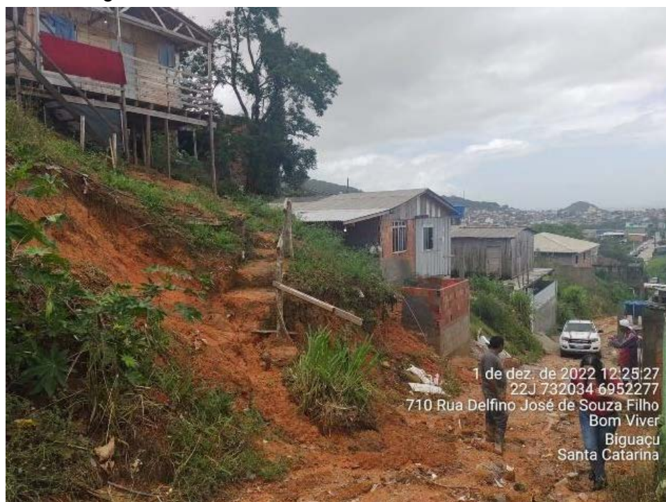
Figura 24. Deslizamento de terra no bairro Bom Viver
