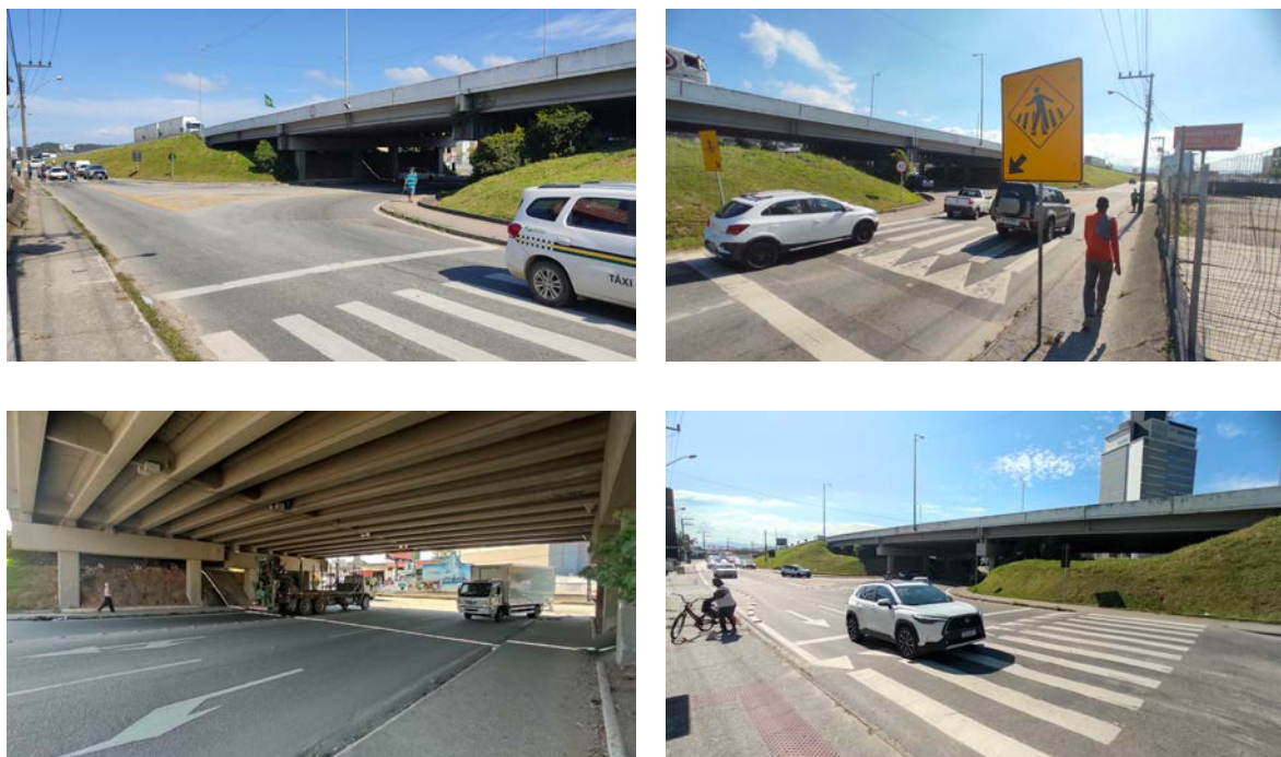
Figura 453. Passarela subjacente a BR-101
