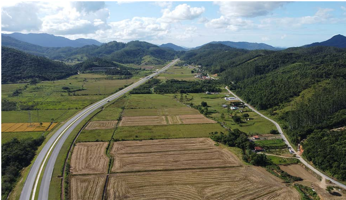
Figura 171. Área de Expansão Industrial - trecho Fazendinha / Fazenda de Fora
