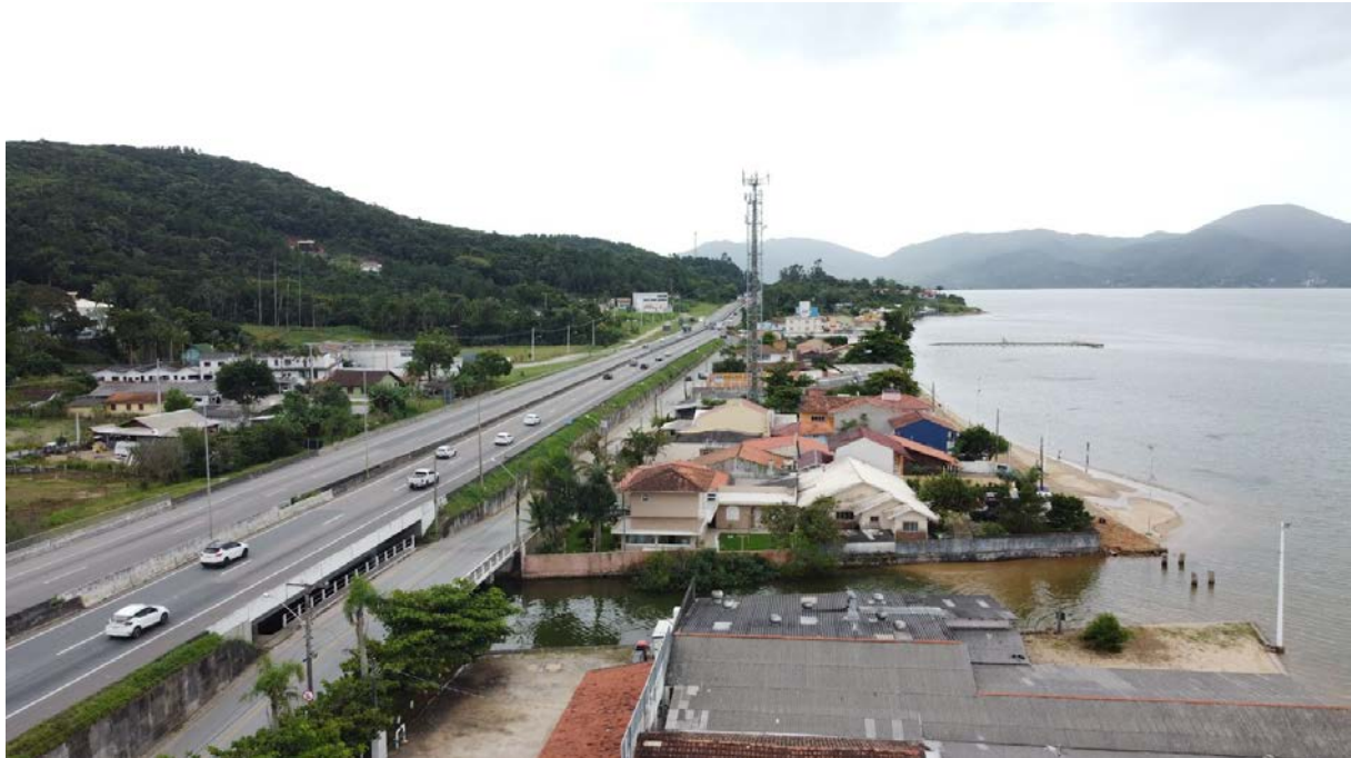
Figura 439. Imagem aérea da BR-101 em proximidade com as edificações localizadas em São Miguel (2023)
