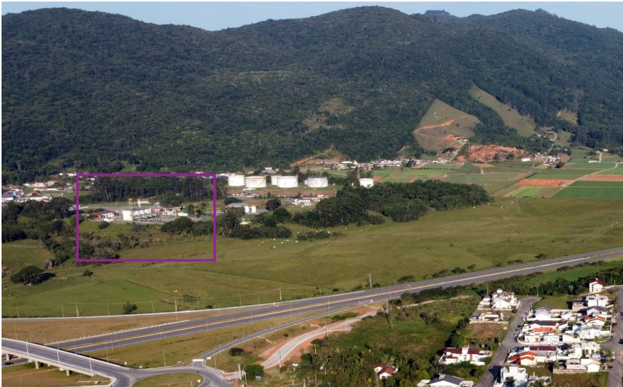
Figura 427. Estação de Compressão de Biguaçu, à esquerda dos terminais da Transpetro
