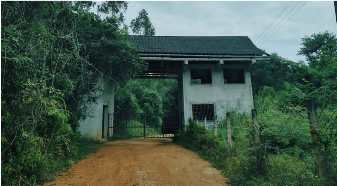
Figura 387. Controle de acesso na Cachoeira do Caldeirão
