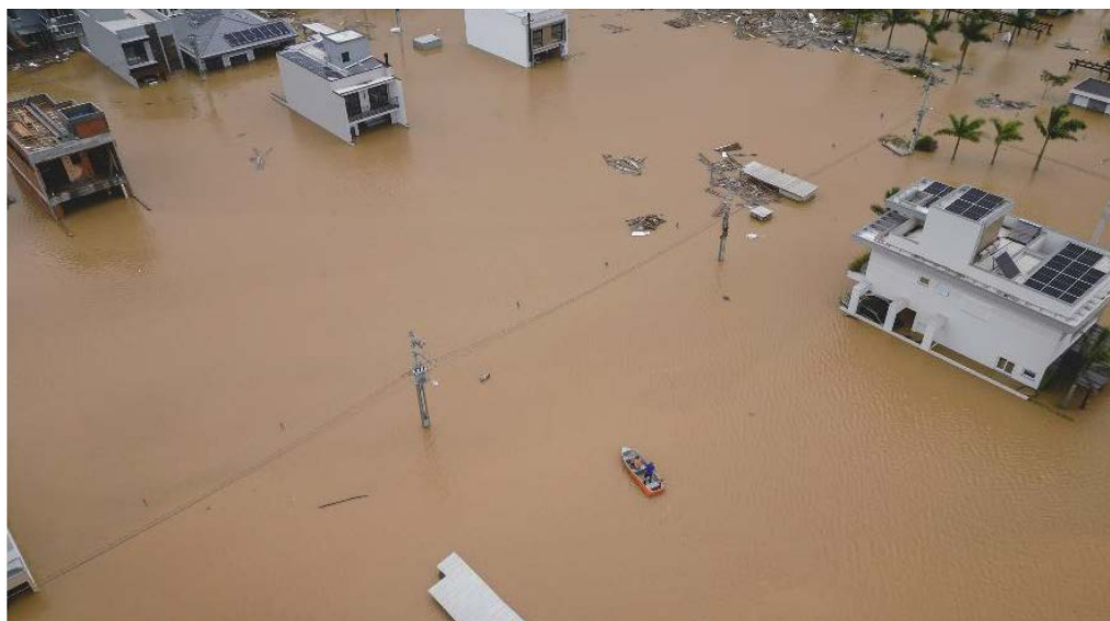
Figura 21. Ocorrência de inundação no Bairro Beira Rio em 01/12/2022: cerca de 600 pessoas desalojadas com prejuízos materiais
